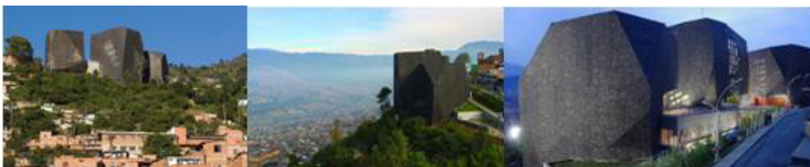
Imagen 02. Vistas Generales. Fuente: http://www.plataformaarquitectura.cl .
