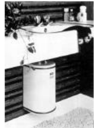
Figura 119 Ubicación inadecuada y adecuada de calentadores eléctricos
