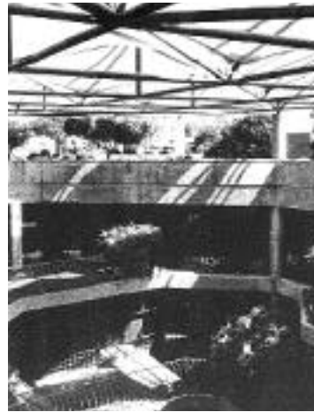
Figura 60 Ejemplo de techo translúcido combinado con ventilación y vegetación
