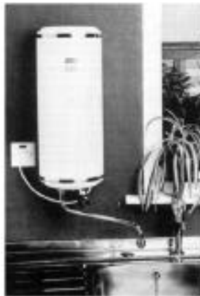
Figura 119 Ubicación inadecuada y adecuada de calentadores eléctricos
