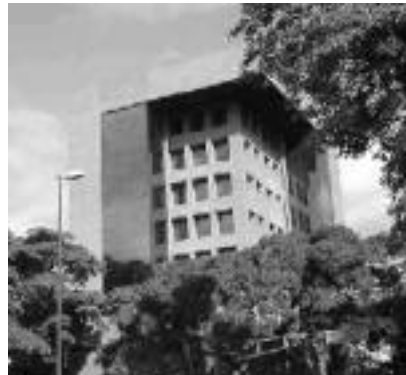
Figura 72 Mitigación de las ganancias solares con proyección del techo sobre paredes y galería de acceso
