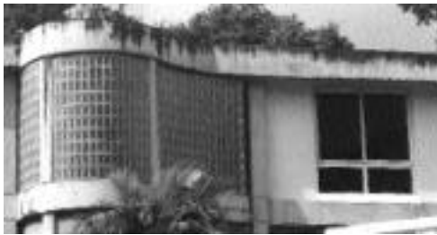
Figura 103 Detalles de bloques de iluminación
