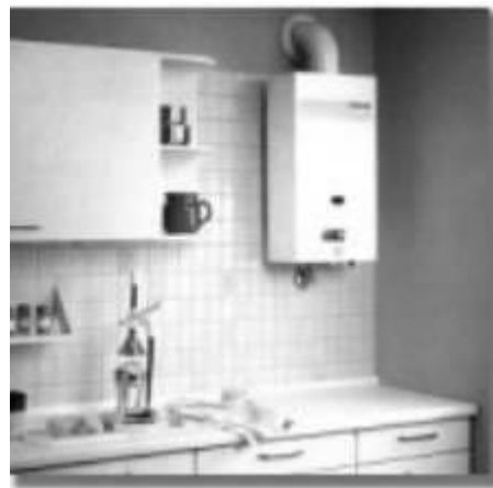
Figura 121 Puntos de gas para calentadores de agua
