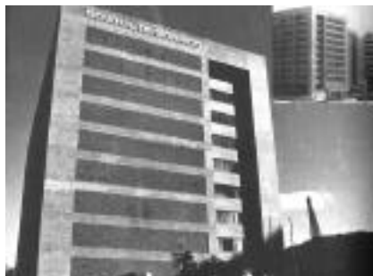
Figura 73 Uso de bloques calados para permitir la ventilación natural en ciertas áreas
