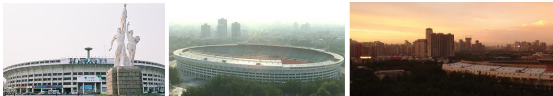
Imágen 2: diferentes vistas del Estadio de los Trabajadores en su estado actual.
