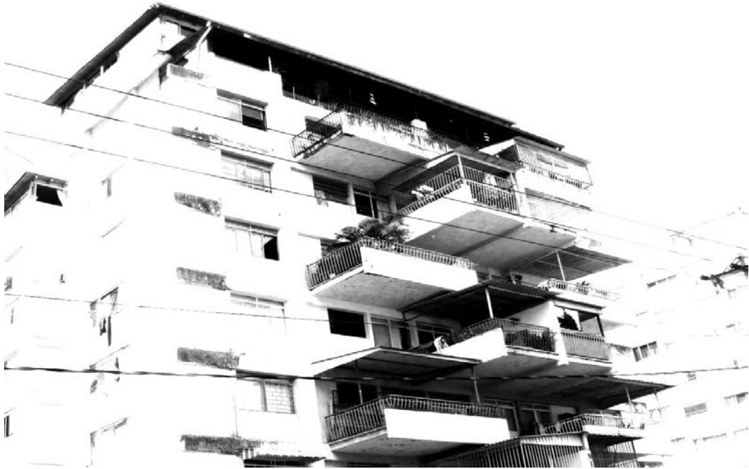
Fig. 0.1 Braceli, M. (2009). Edificio en Chacao
