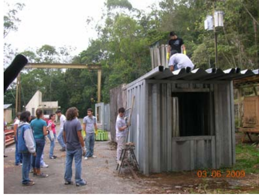
Foto 2. Deconstrucción de prototipo. Fuente: propia
