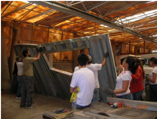
Fotos 22, 23, 24 y 25. Organización en cuadrillas de estudiantes para las diversas labores de producción del prototipo modular con tecnología Sipomat Fuente: Propia
