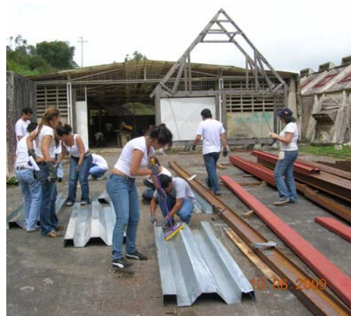
Foto 5. Limpieza de material para re-utilizarlo Fuente: Propia
