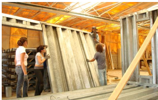
Estudiantes aprendiendo el manejo de herramientas de construcción armando planos portantes
