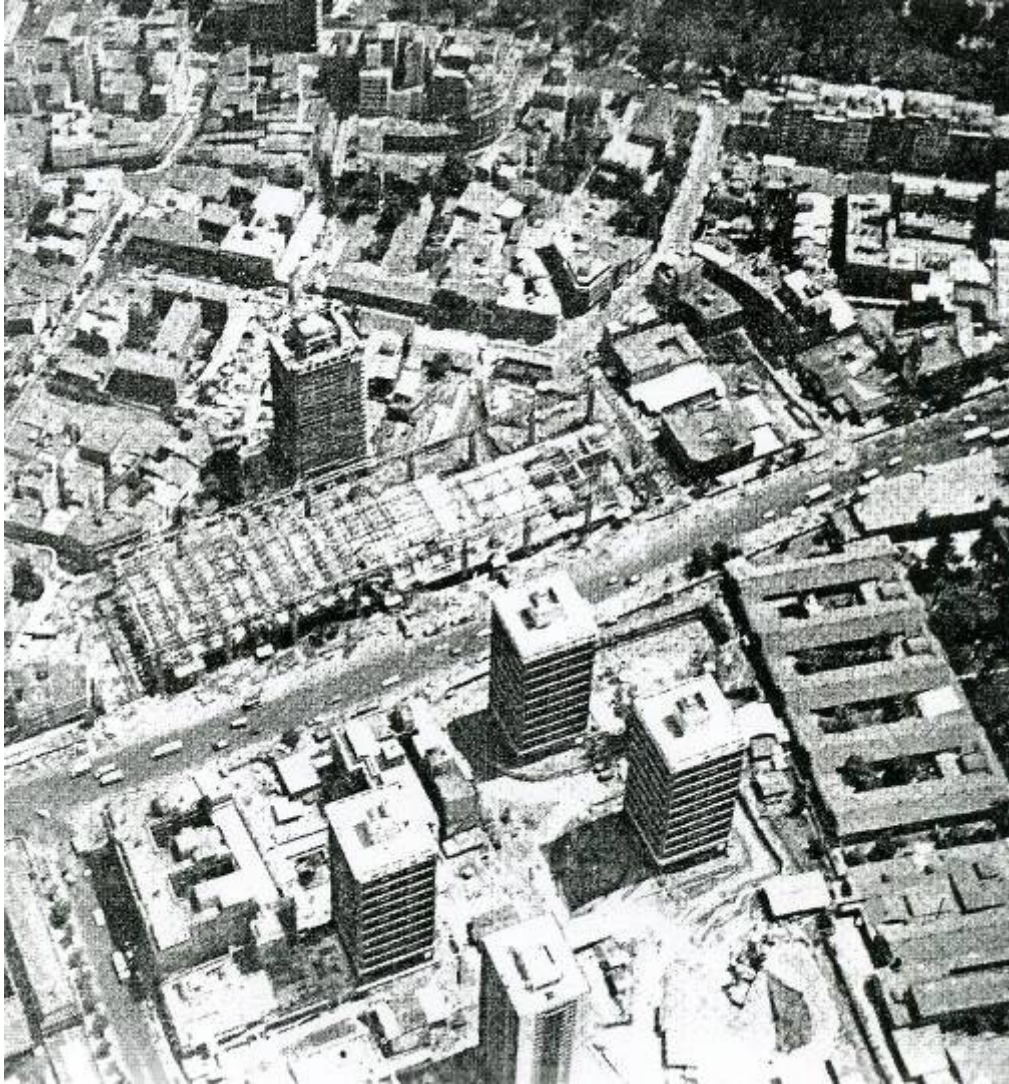
Fig. 6: Remodelación San Borja y placa y torre del secretariado de la sede de la UNCTAD III en construcción. Fuente: Revista AUCA (1972), N°22.
