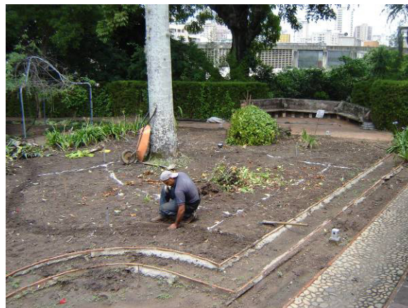
Imagen 12. Proceso de instalación del jardín principal de la Quinta de Anauco (2008) Fuente: Fotografía del autor
