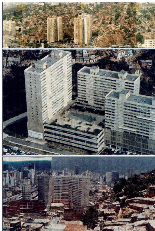
Imagen11:Conjuntos habitacionales del CSBCA en San Agustín del Sur (1984). Fuente: fotos del autor.
