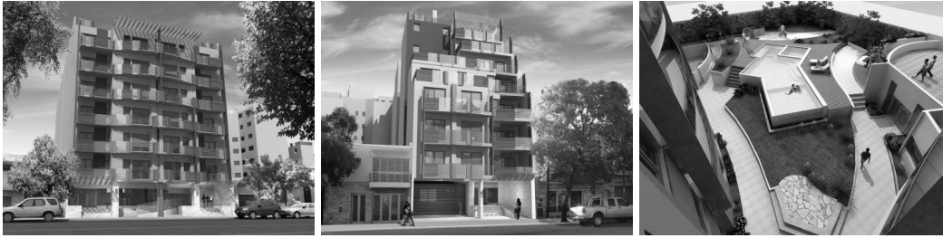
Fig. 4, 5, y 6. Cofico Residences. El complejo edilicio unifica parcelas en L sobre Bedoya y Lavalleja. En la intersección de ambas se ubican los servicios y amenities. Fuente: Catálogos y páginas web del emprendimiento.
