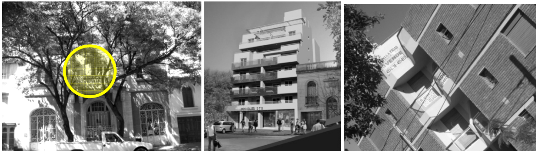
Fig. 1, 2 y 3. Edificaciones de viviendas colectivas construidas en los predios antes ocupados por viviendas unifamiliares de fines del siglo XIX y principios del XX, que fueron demolidas durante el periodo estudiado. Fuentes: Fotos 1 y 3: M. Liborio, 2009. Foto 2: www.elinmobiliario.com
